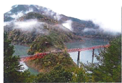
▲奥大井湖上駅の周辺風景 寸又峡温泉から車で約30分、南アルプスあぶとラインも好評。
